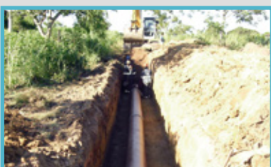
Adutora de água (em PRFV) Trimumu Lote III.
