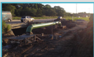
Travessias aéreas sobre rios executadas em aço (DN 450).
