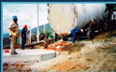
Construção de bases de concreto e assentamento de reservatórios de água potável construídos com Fibra de vidro – capacidade: 50m 3 cada – (Sabesp – Ilhabela / SP).
