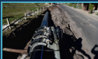
Adutora Gravatá. Obra Prolagos.
