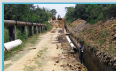
Adutora de Água (em PRFV) Trimumú Lote II.
