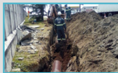
Adutora de Água. Obra Esgoto Aeroporto.
