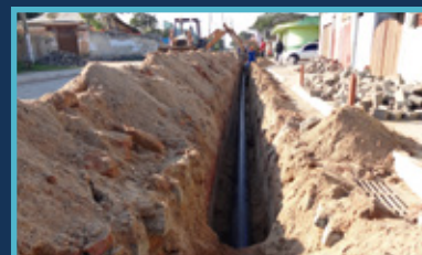
Adutora de Água Setor 14. Obra Prolagos.
