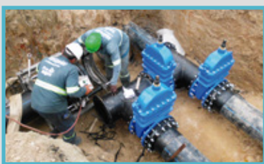
Adutora Jardim Esperança PEAD DE 350mm.
