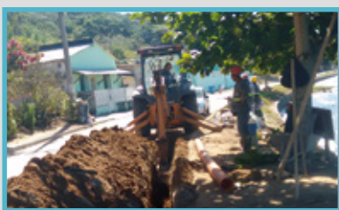
Rede de Esgoto. Obra Baleia.
