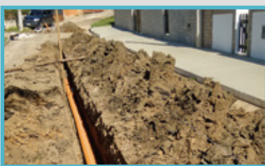
Rede Coletora de Esgoto. Obra Prolagos.
